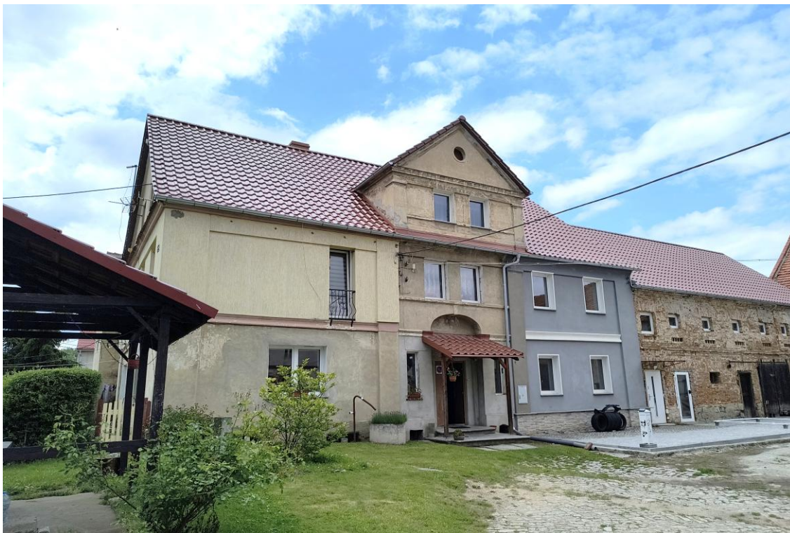
Widok od południowego wschodu
