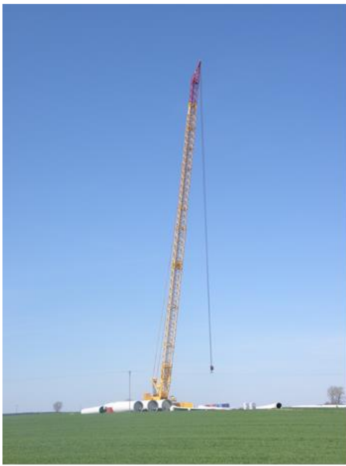
Ryc. 3. Fotograficzna dokumentacja budowy elektrowni wiatrowej. (źródło: EMPEKO)
