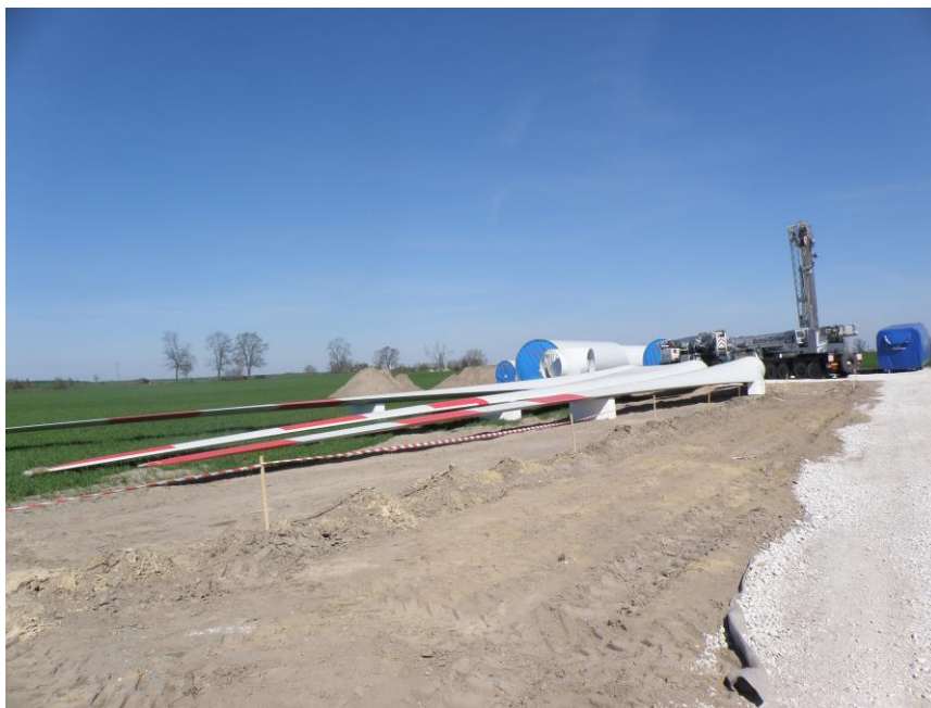
Ryc. 2. Fotograficzna dokumentacja budowy elektrowni wiatrowej. (źródło: EMPEKO)
