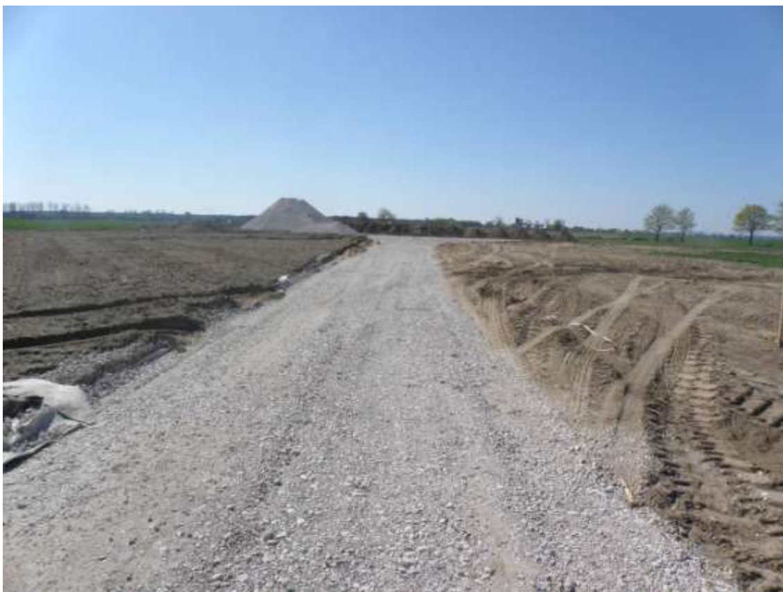
Ryc. 3. Przykładowy plac montażowy w fazie realizacji. Na pierwszym planie droga techniczna, w tle plac manewrowy. Foto: M. Przybycin.
